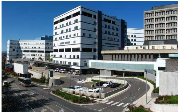
Afb. 1: Buitenaanzicht ziekenhuis Melbourne
